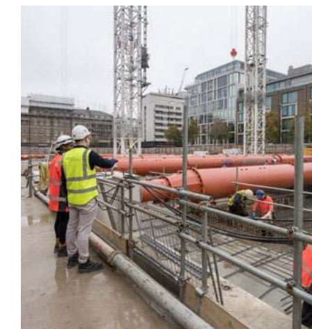
25 Baker St. W1 site
