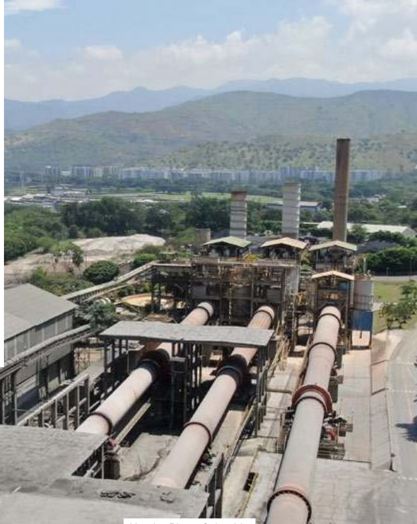
Yumbo Plant, Colombia
