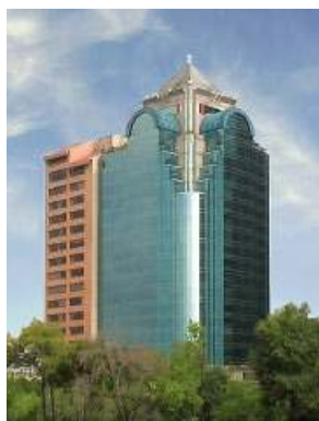
Mexico, Edificio Forum
